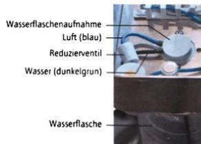
Abb. 4) Einbaubeispiel des Reduzierventils
